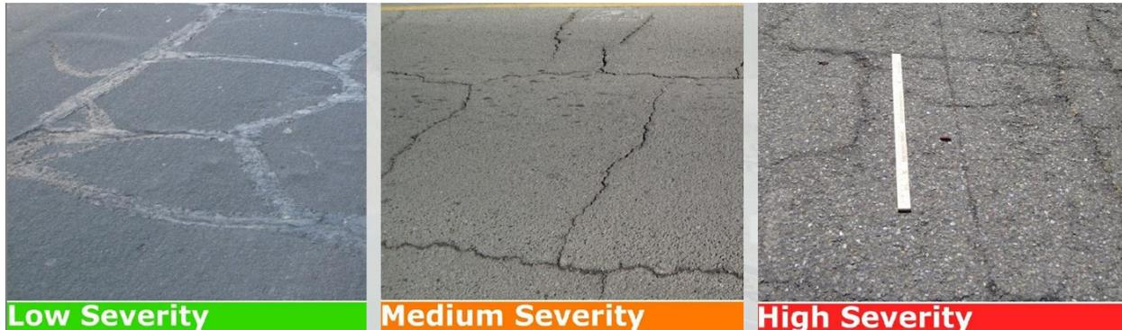
*Image 2: Block Cracking*
